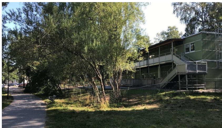
Provisorisk skolpaviljong i två våningar är belägen inom planområdet. Vy från sydväst.
