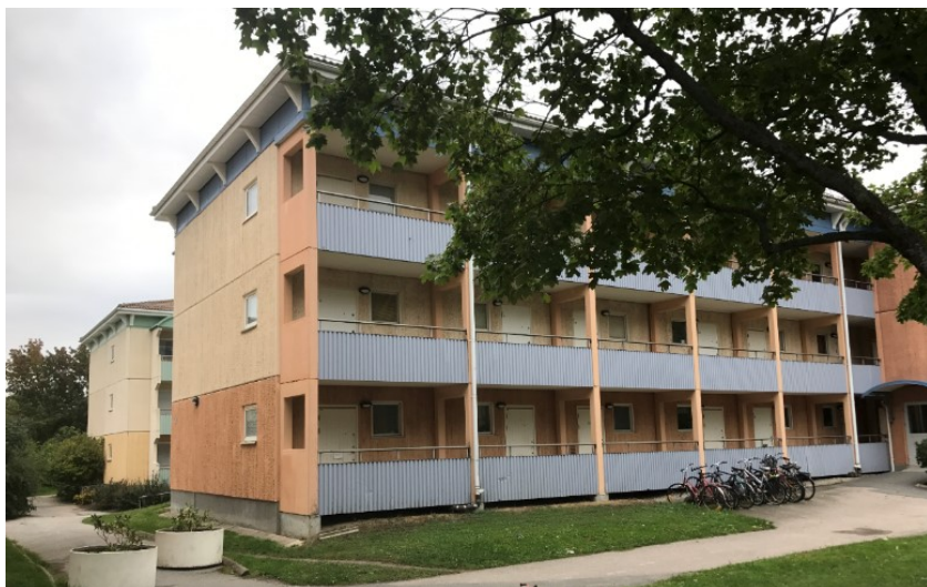
Bebyggelsen inom fastigheten Vårdaren 1. Byggnaderna mot Söderberga Gårdsväg har loftgångar.
