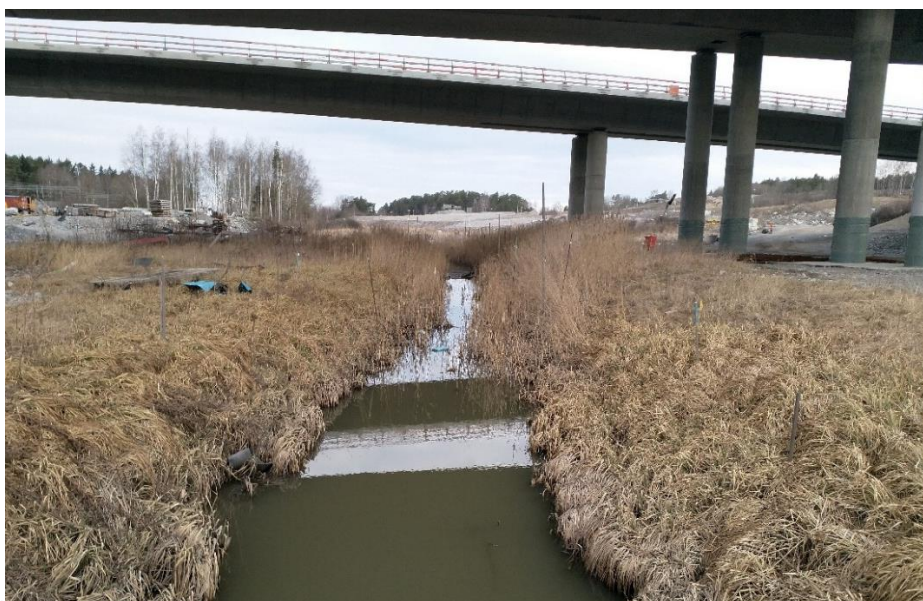
Figur 14. Bällstaån under nya vägbroar för Förbifarten/E18 vid Hjulsta trafikplats. Vy mot nordväst.
