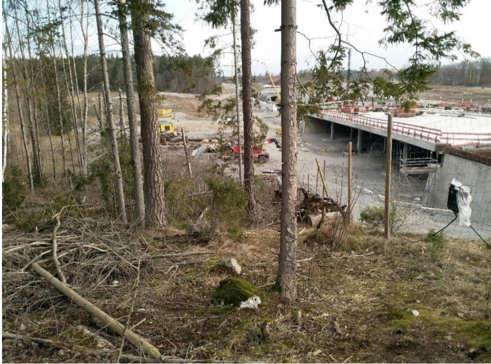
Figur 13. Skogskant längs Förbifarten och planerad markkabelsträckning inom Igelbäckens kulturresevat.
