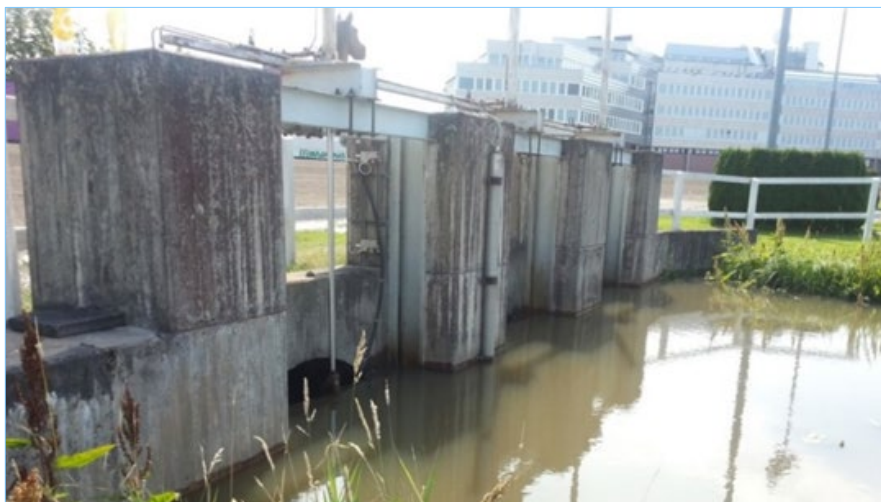
Solvalla travbana. Överfallsluckor inne på travbanan dämmer upp vattnet under tävlingarna. Foto: Tobias Fränstam
