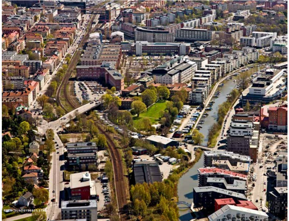
Figur 11. Vy över centrala Sundbyberg i sydöstlig riktning, järnvägen till vänster och Bällstaån till höger i bild. (Källa: Planförslag Sundbybergs nya stadskärna)
