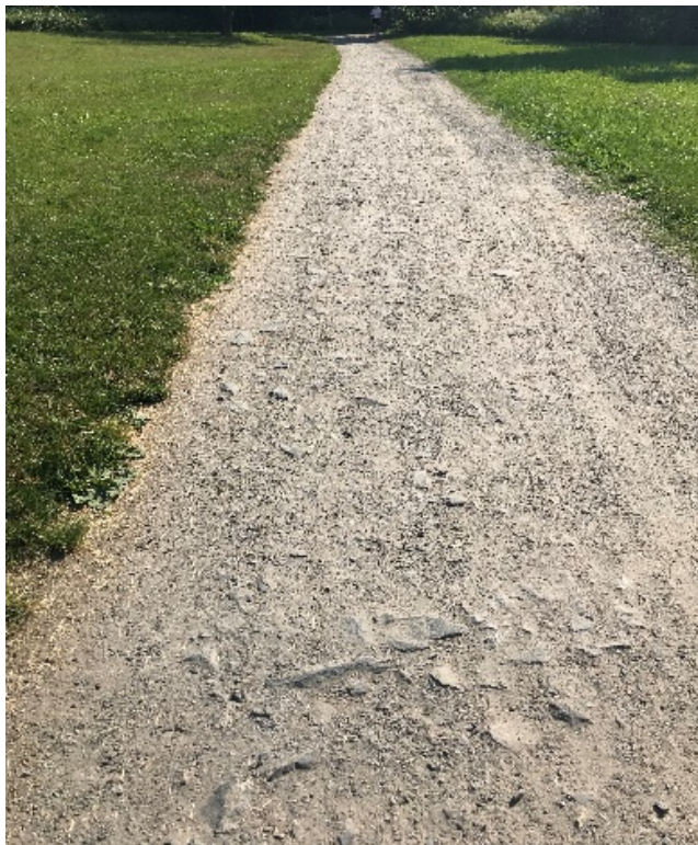
Erosion på sträckan mot Stora Sköndal
