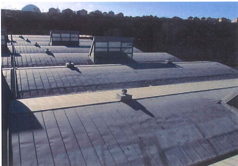
Befintligt plåttak sett från Johanneshovsbron
