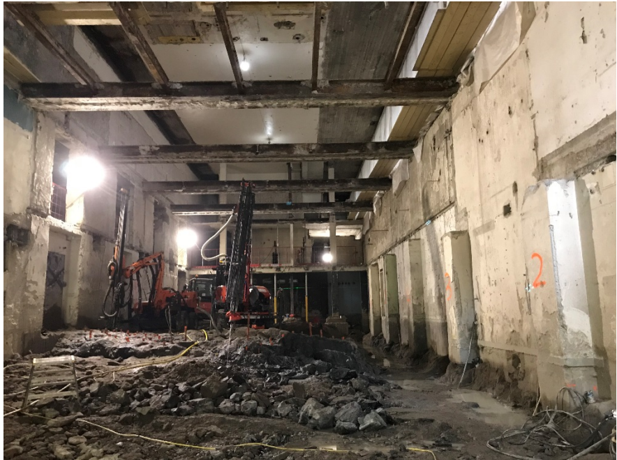
2 Bergspräckning i västra flygelns källare
