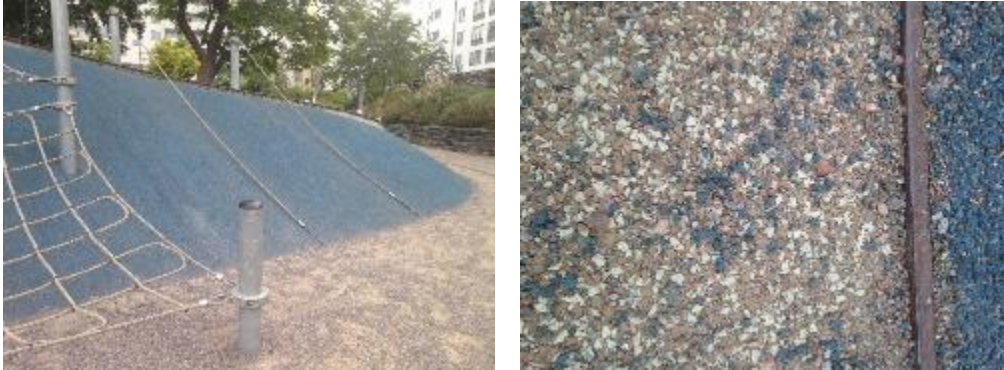
Till vänster gummibelagd vägg och till höger lösa blåa granulatbitar på lekplatsen Blomsterdalen. Bildkälla: Sofie Lindgren.
