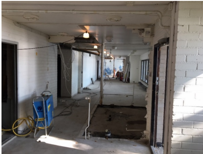
Figur 1, Byggnad under ombyggnationen.
