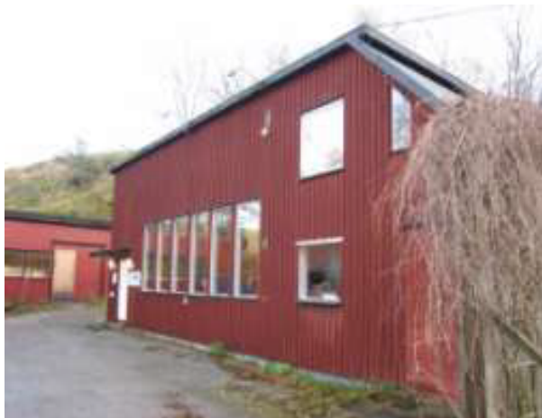
Bilden visar en av de tre byggnaderna på fastigheten. Byggnaden är uppförd på 1960- talet och nyttjas som verkstad/snickeri.
