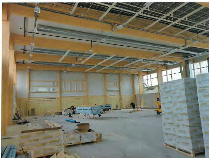
Interiör bild från idrottshallen (augusti 2019).
