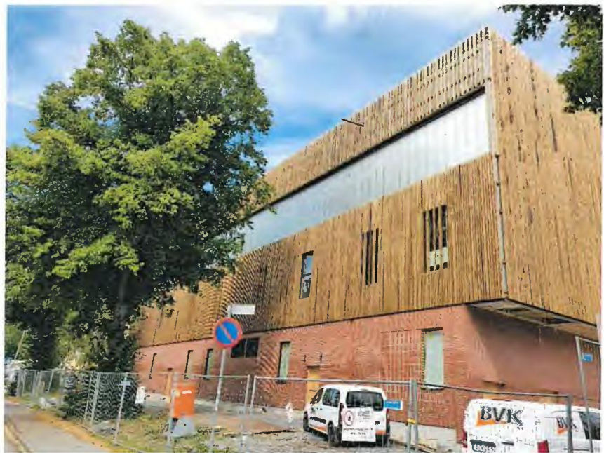
Fasad mot Klensmedsvägen med tegelmurat sockelplan och färdigmonterade träpaneler på övre plan (augusti 2019).
