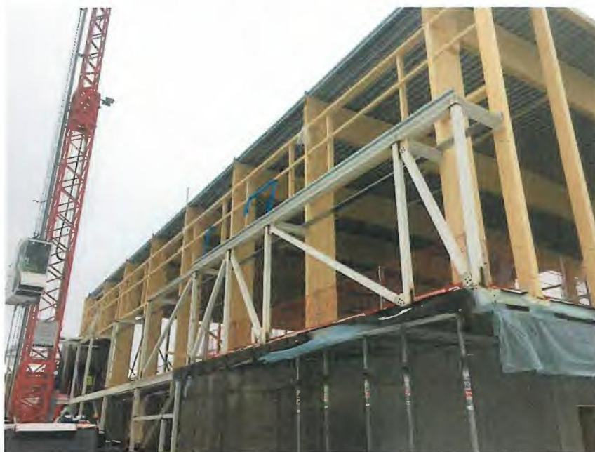
Montering av träkonstruktion på övre plan (februari 2019).
