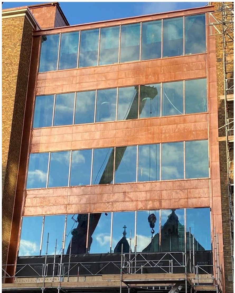
Ett av de nya fasadpartierna mot Folkungagatan. Foto Johan Meyer
