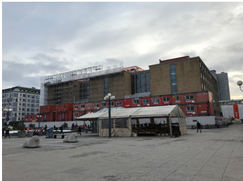
Takvåningen färdigställd, partier bytta, fasadställningar monteras ned.
