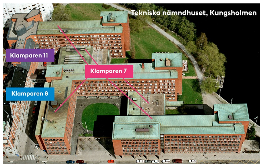
Tekniska nämndhusets olika fastigheter.
