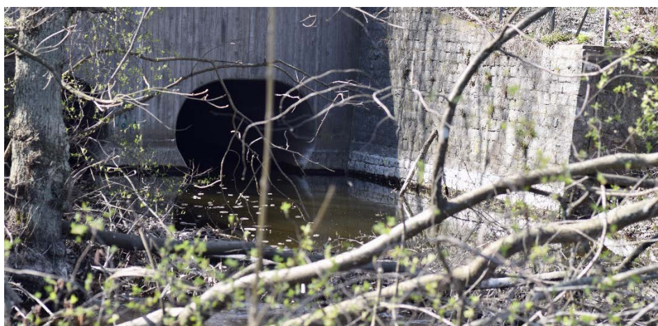
Kulvertering där pendeltågspåret korsar Forsån. Foto: Maya Miltell.
