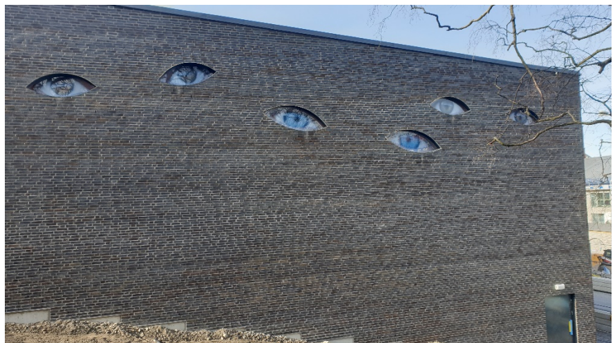
Konstverk på idrottshallens östra gavel.
