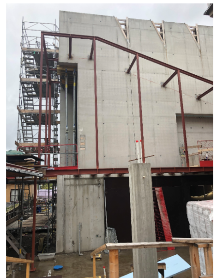
Del av fasad under uppförande (2020-05-11)
