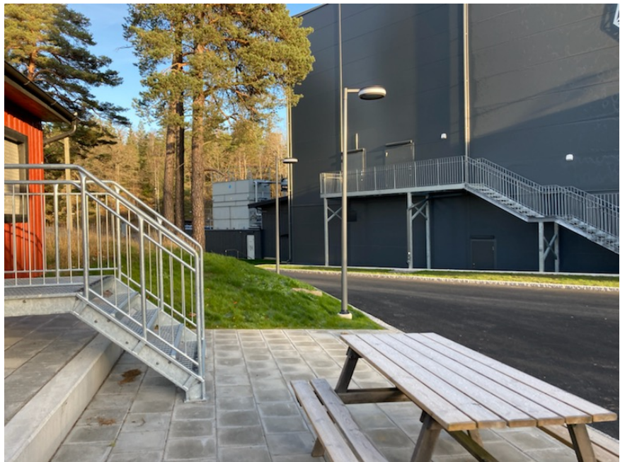
Fasad västra sidan, sett från befintlig kiosk. Foto: Ritta Hannah
