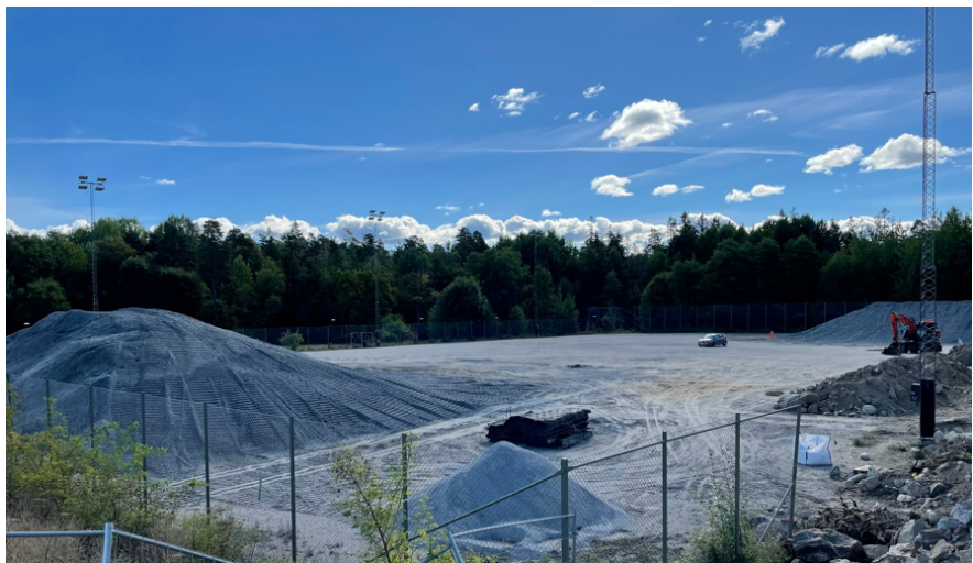
Bild 2: Förbelastning massor
