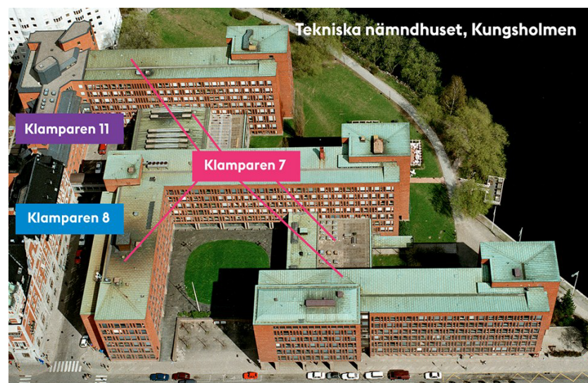
Tekniska nämndhusets olika fastigheter.
