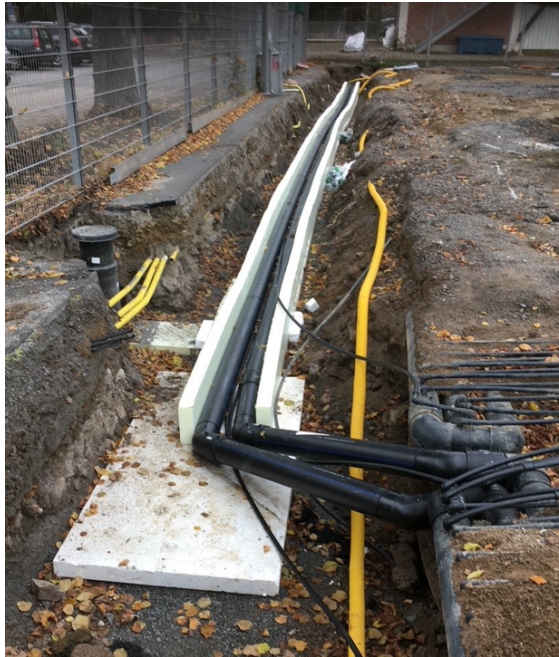
Figur 1: Nya fördelarrör till kylslingorna. Foto Johan Stagnebo
