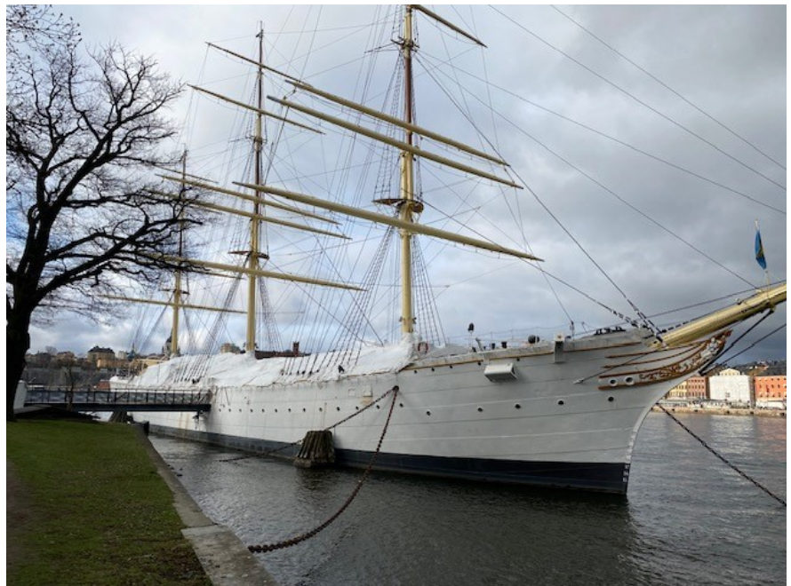
HMS af Chapman under renoveringen.
