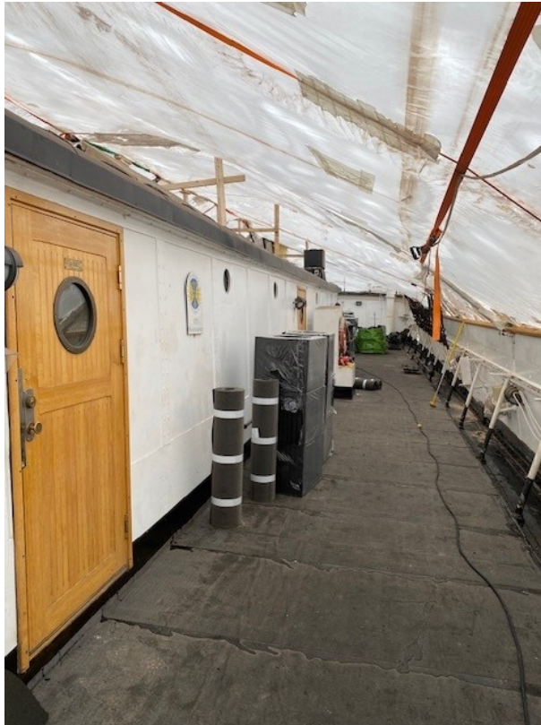
Tätskiktet innan trädäcket monteras.
