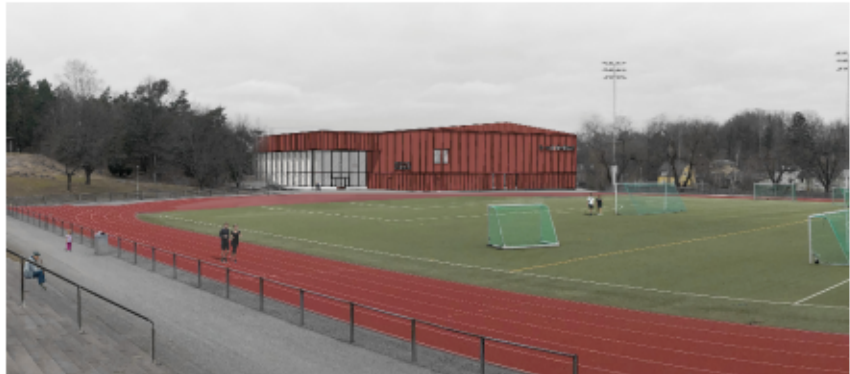
Hagsätra is- och idrottshall.
