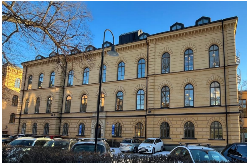
Norra fasaden före renoveringen.
