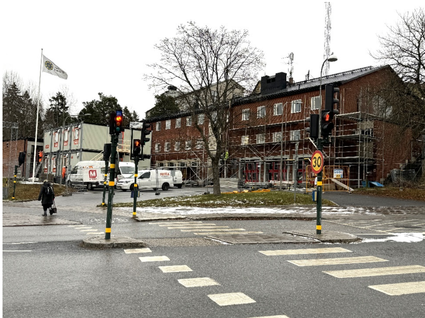
Etablering och ställningsupbyggnad påbörjad.
