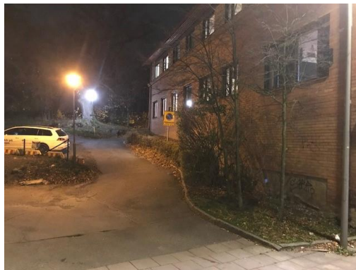
Fasad mot järnvägen
