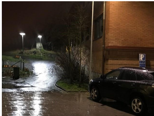
Fasad mot järnvägen
