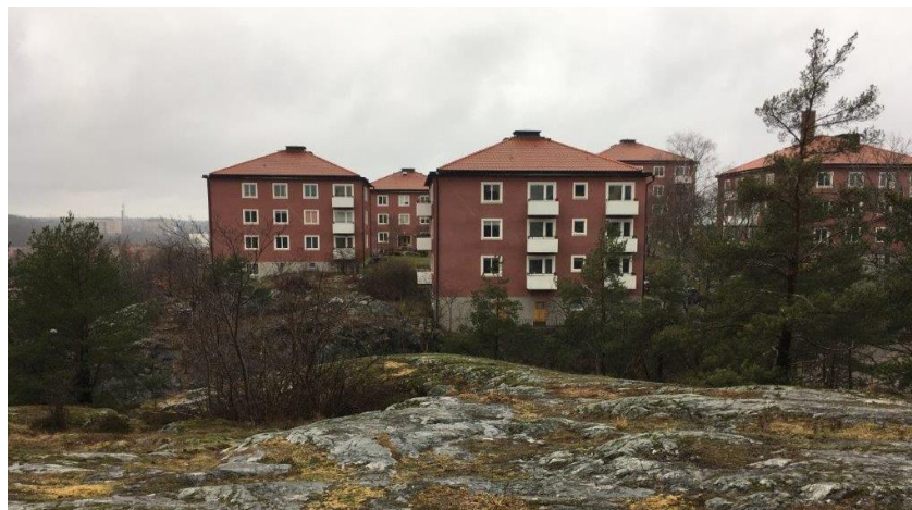
Punkthusen inom kvarteret Spillkråkan, omgivna av vegetation, ligger på en höjd från korsningen Sigfridsvägen/Schlytersvägen.
