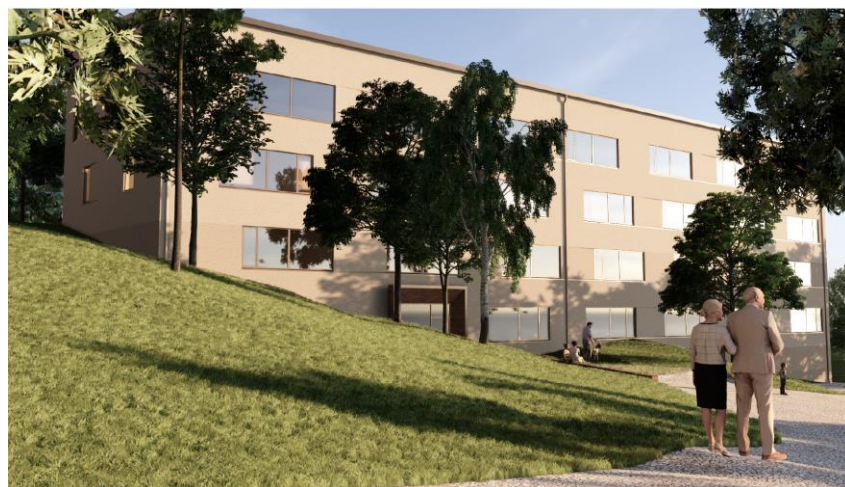
Vy mot ny skolbyggnad från gångvägen längs den sydvästra fasaden.
