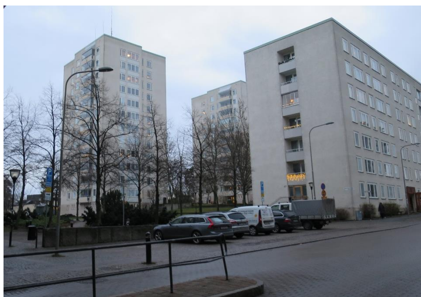
Foto som visar del av den befintliga bebyggelsen på Nybohovsbacken. (Ramboll, 2019).
