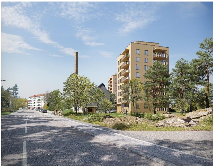
Det södra punkthuset placeras indraget från Folkparksvägen för att synliggöra panncentralen (bild: Nyréns arkitekter).
