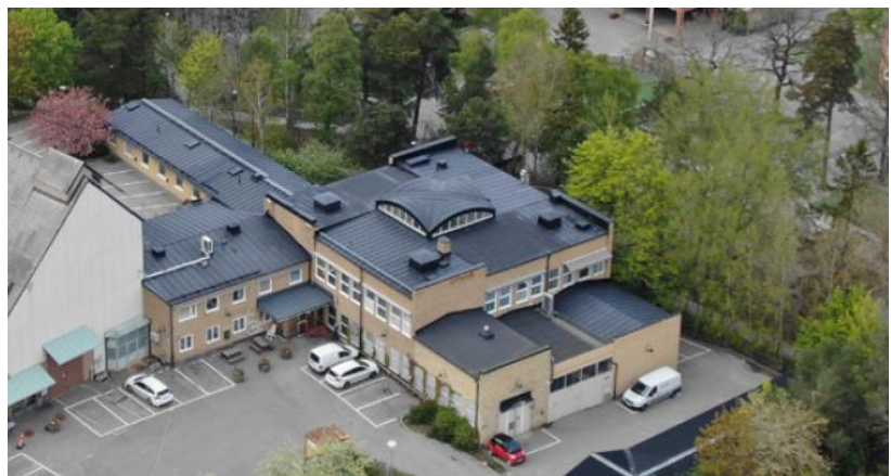
Kontorsbyggnaden med senare tillbyggnader på södra och norra fasaden.
