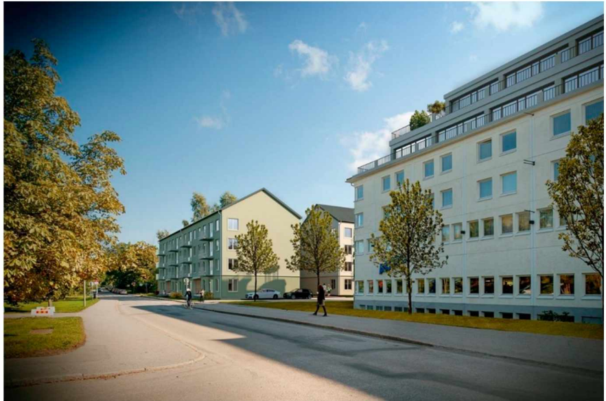
Vy från Västertorpsvägen, hotellbyggnad med påbyggnad till höger i bild.
