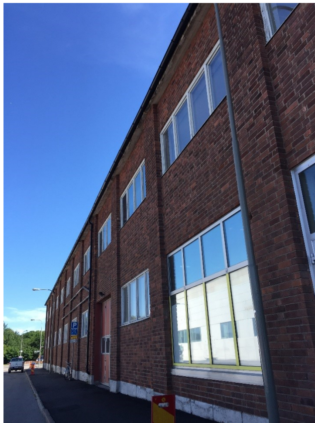
Byggnaden på Lönelistan 1, långsida mot Elektravägen.
