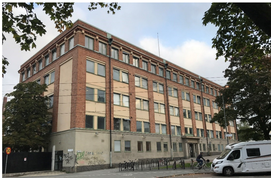
Beckershuset vid Lövholmsvägen som föreslås bli skola. Bild: Stadsbyggnadskontoret.
