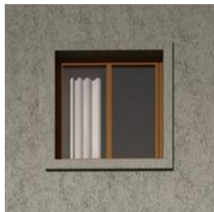
Balkongdörr- och fönsteromfattningar utförs i samma kulör som fasad. Omfattningarna utförs som upphöjd relief i puts som ger en skuggverkan på fasaden. Bild Dinell Johansson
