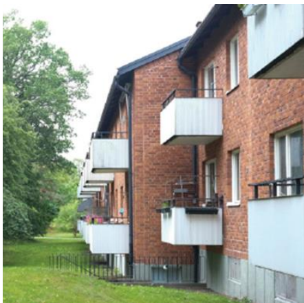
Baksidan av husen på Puckgränd. Foto Nyréns
