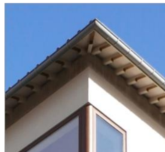
Takfoten ska utformas utstickande med synliga taktassar. Det skyddar fasaden och ger byggnaden ett lättare intryck. Referensbild Dinell Johansson
