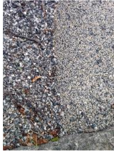
Grå gummibeläggning intill grus på lekplatsen Sannadalsplatån. Bildkälla: Sofie Lindgren
