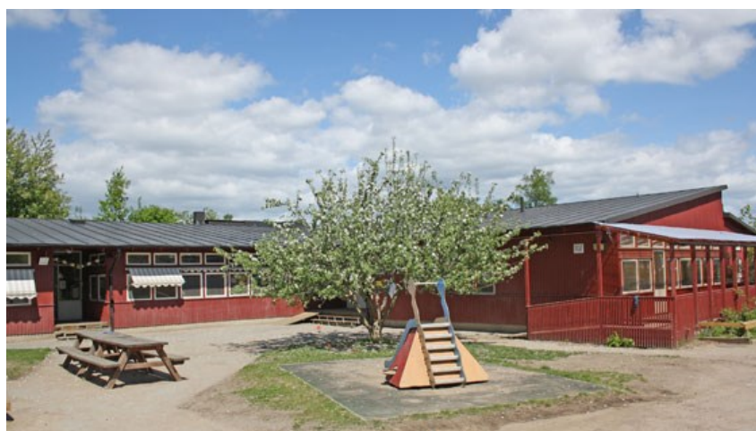
Befintlig byggnad, en vinkelställd typförskola i en våning uppförd 1968
