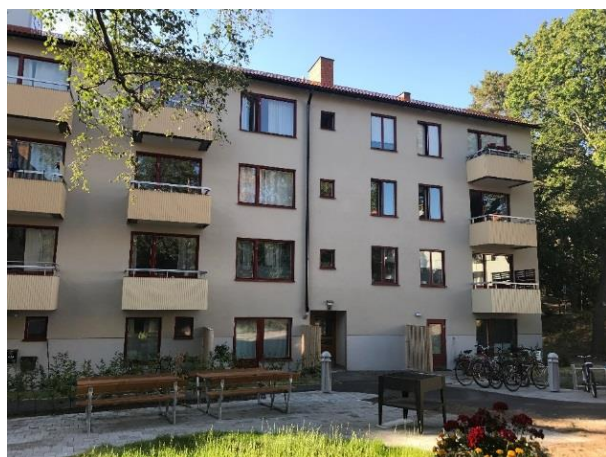
Befintlig bebyggelse sett från gården
