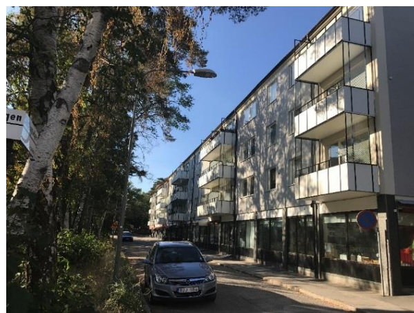
Störtloppsvägen med lokaler på bottenvåningen av befintlig bebyggelse i fastigheten Backhoppet 2
