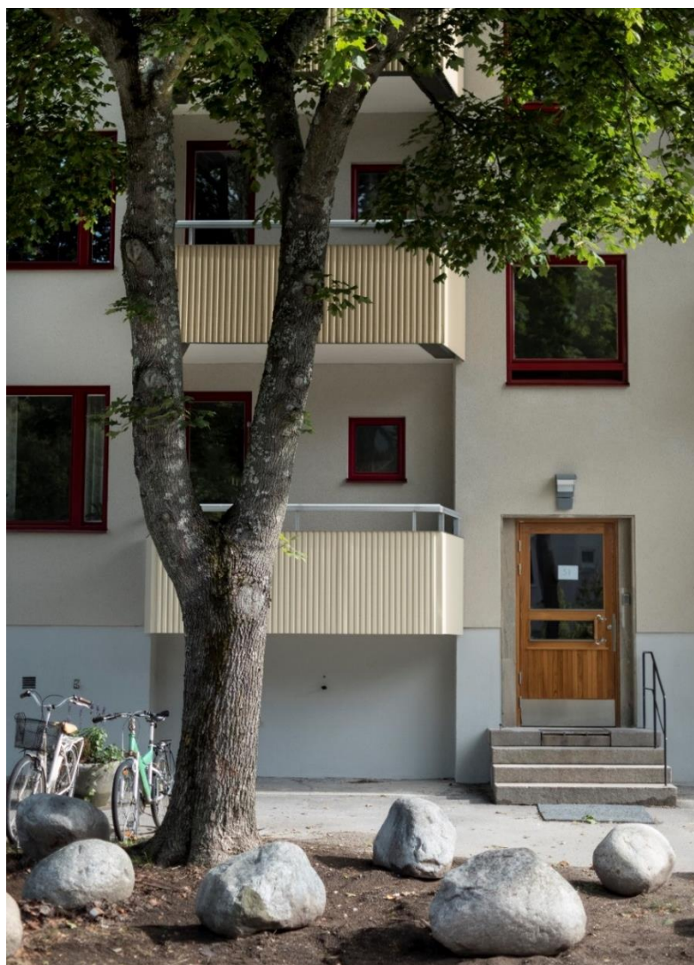
Befintlig bebyggelse i kvarteret sett från Lugntorpsvägen
