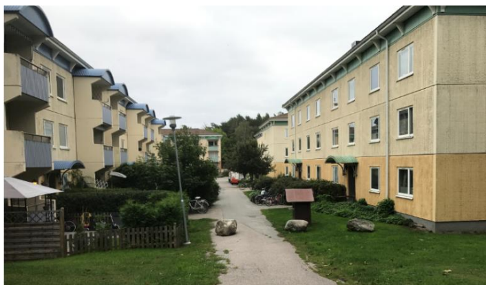
Bebyggelsen inom fastigheten Vårdaren 1. Byggnaderna mot Söderberga Gårdsväg har loftgångar.
