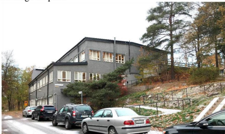
Befintlig byggnad, tidigare panncentral från 1950-talet.
