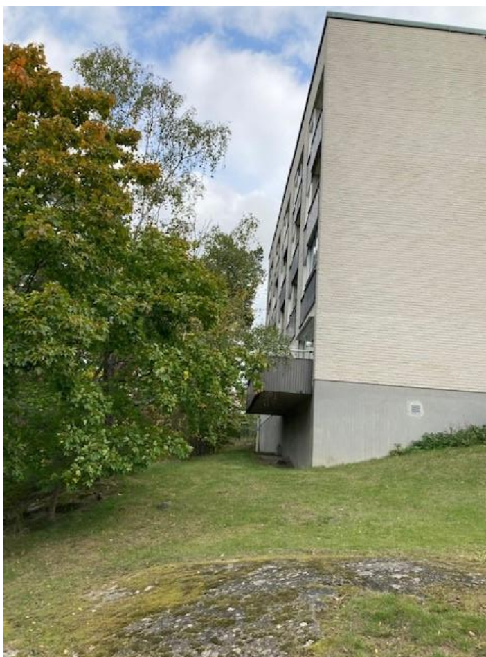
Hus D med betongsockel och kalksandstensfasad.
