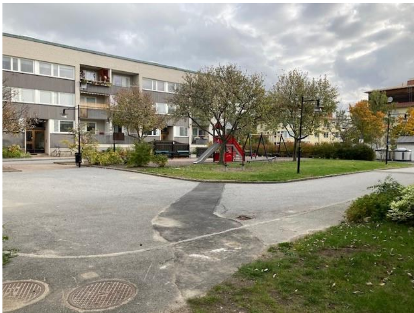
Hus A med fönsterbröstningar och balkongfronter i korrugerad plåt och plåtinklädda fönster.
