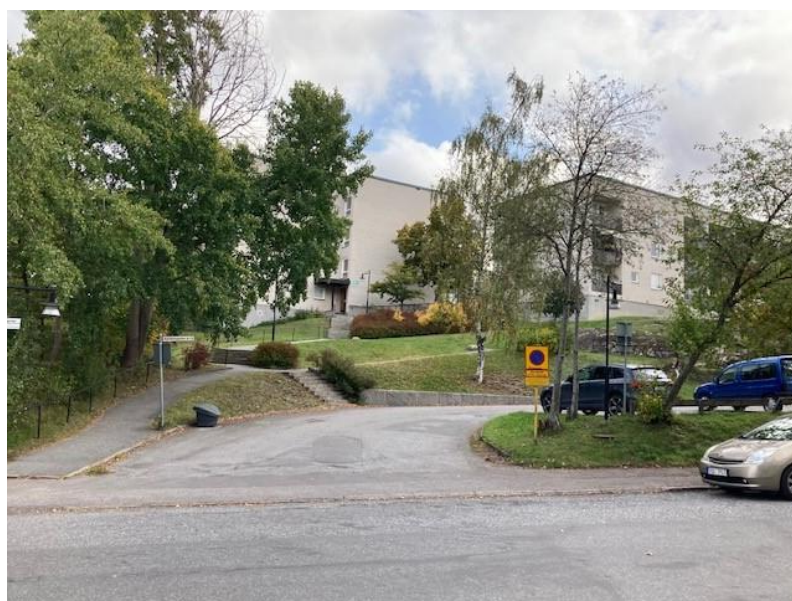
Entréer och befintliga byggnader inom planområdet sett från Aprikosgatan.
