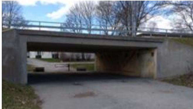
Tunnel under Spånga Kyrkväg, passage med många utmaningar
