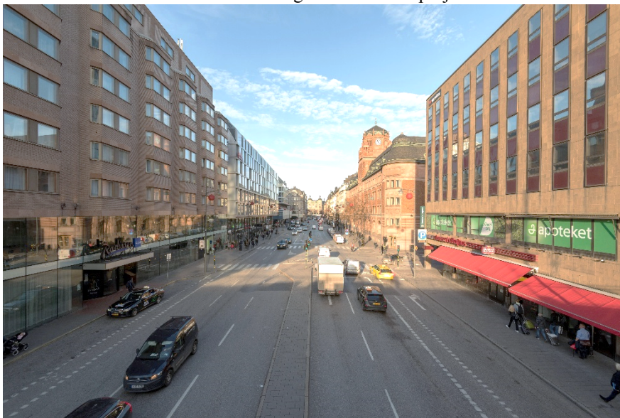
Vy från Klarabergsviadukten norrut innan ombyggnad
