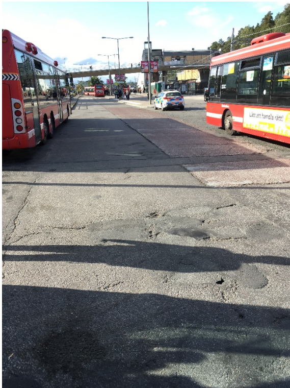
Figur 3. Potthål och gamla lagningar
