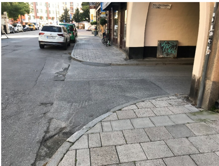
Figur 6. Tillfällig tillgänglighetsåtgärd samt pott hål
