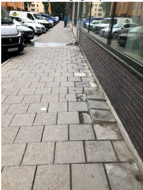
Figur 2. Lösa gångbaneplattor
