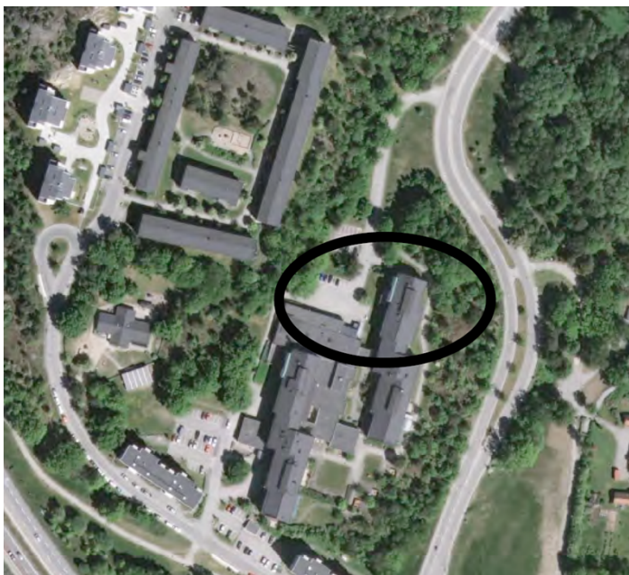
Lokalisering av etapp 4 ovanifrån. Före bebyggelse, flygfoto på rivet sjukhem.
