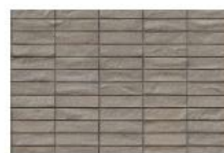
Golv- och ramptäckning: mörkare marktegel, stapelförband
