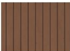
Undertak och väggtäckning entréport: trä, ytbehandling med pigmentering i märkbrun kulör
