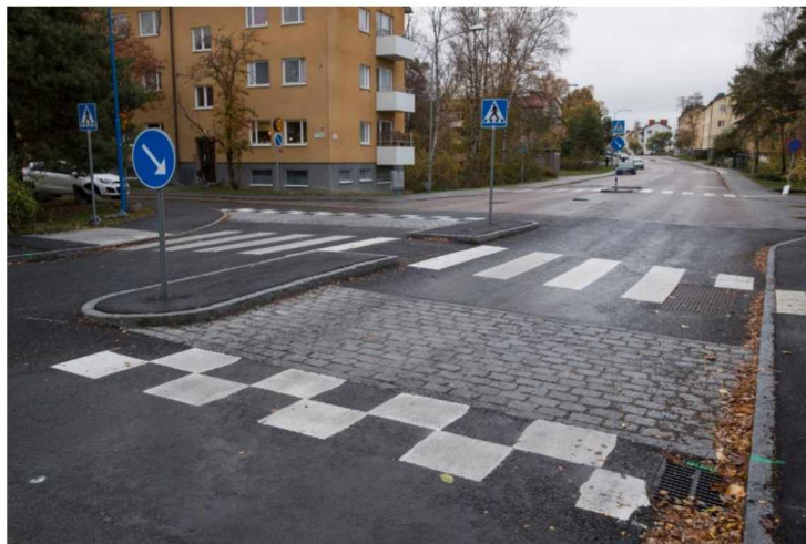
Bild 3: Upphöjt övergångsställe med refug och påfartsramp samt lång nerfartsramp
