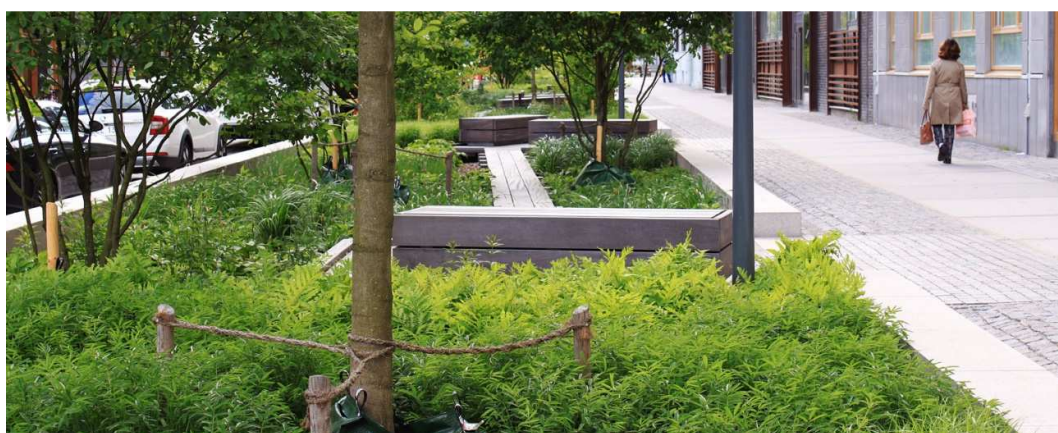
Exempel på förstärkt dagvattenhantering i ett exploateringsprojekt: Regnbäddar på Jaktgatan i Norra Djurgårdsstaden. Foto: Lennart Johansson
