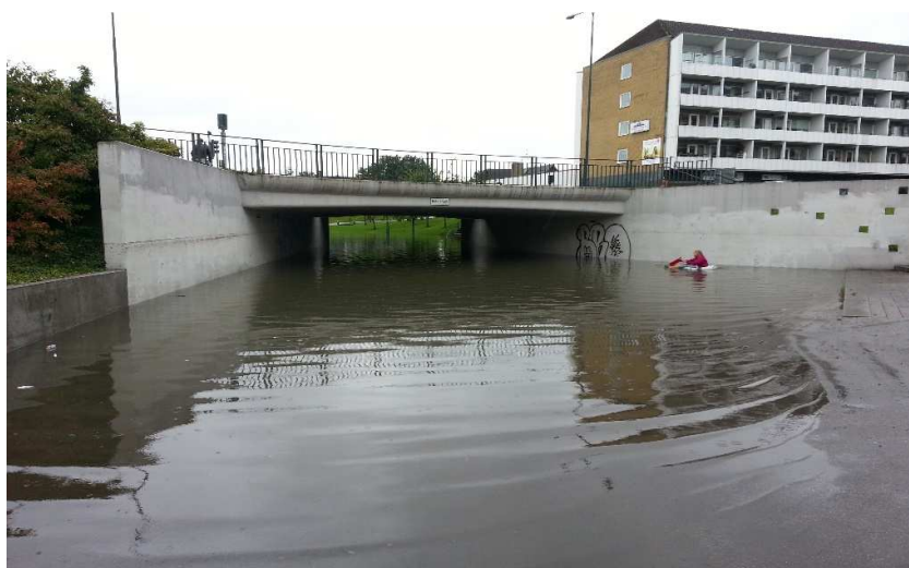
Översvämmad GC-tunnel i Malmö i samband med skyfallet år 2014. Foto: Stefan Milotti
