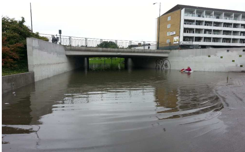
Översvämmad GC-tunnel i Malmö i samband med skyfallet år 2014. Foto: Stefan Milotti
