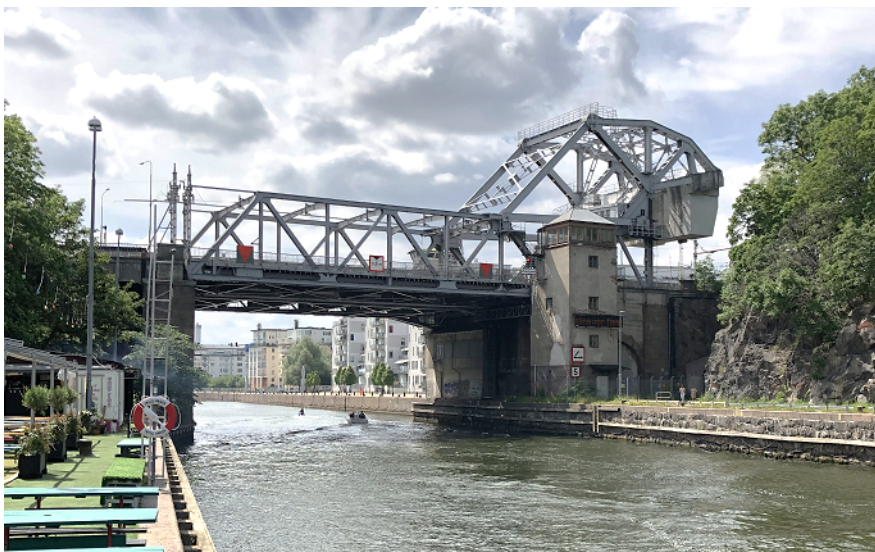
Bild 3. Befintlig bro, sedd norrifrån.
