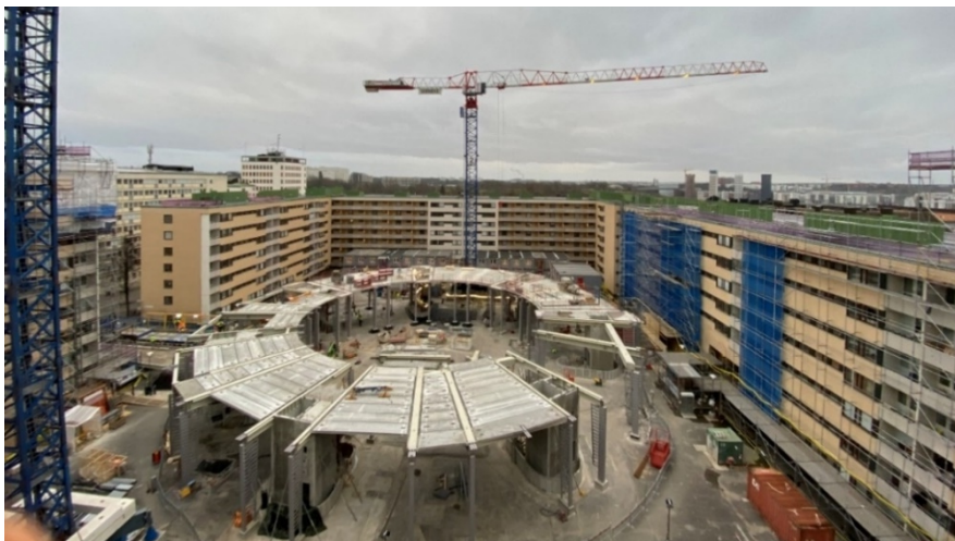
Bild över gårdshuset där uppförandet av stommen är påbörjad.
