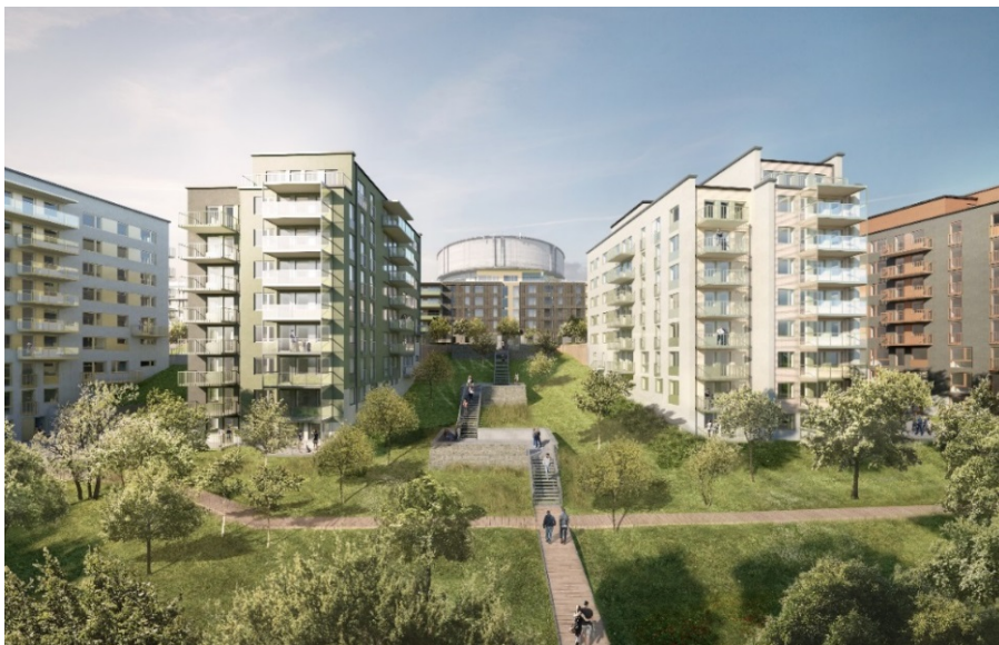
Park med trappa upp till Tenstaterrassen. Vattentornet i fonden (ÅWL arkitekter).
