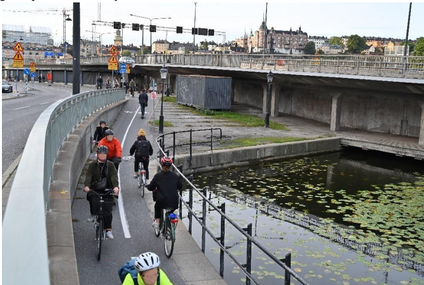
Bild 8. Cykelbana mot Gamla stans tunnelbana
